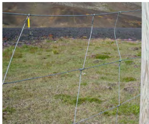
Mynd 8. Vírnet á að vera þannig gert að allir strengir strekkist jafnt. (Mynd Grétar Einarsson)
