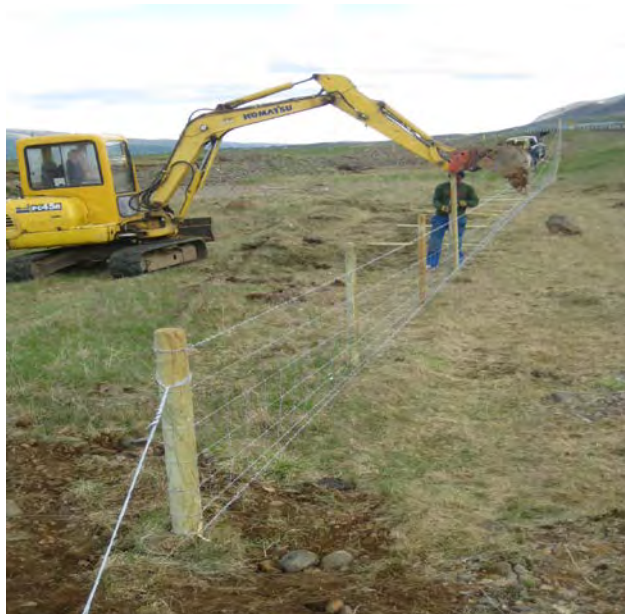
Mynd 33. Litlar vélgröfur spara ómælt erfiði við uppsetningu á girðingum. (Ljósmynd Grétar Einarsson).
