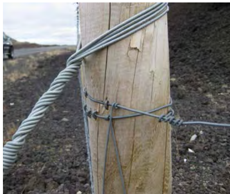
Mynd 4. Stög þurfa að vera fjórföld, vel vafin rétt fyrir ofan girðingastrengi. (Ljósmynd: Grétar Einarsson)
