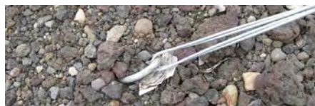
Mynd 5. Heppilegast er að vera með steypustyrktarjárn frá stagbotni upp á yfirborð til að lengja endingartímann og auðvelda viðhald. (Ljósmynd: Grétar Einarsson)
