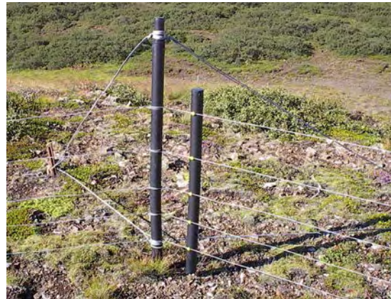
Mynd 1. Frágangur horn- og aflstólpa skiptir sköpum fyrir endingu og viðhald girðinga. Myndin sýnir hornstólpa og stög boruð í klöpp. (Ljósmynd Grétar Einarsson)
