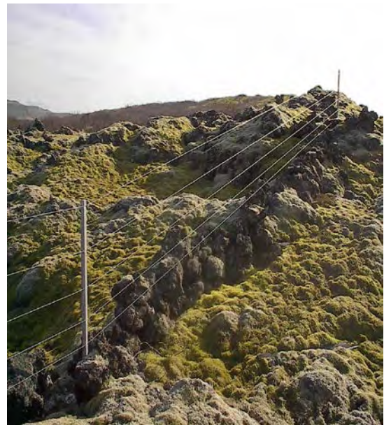
Mynd 21. Undirgirðingar og undirhleðslur eiga að vera ótengdar aðalgirðingu. Myndin sýnir hleðslu úr hraungrýti. (Ljósmynd Grétar Einarsson.)
